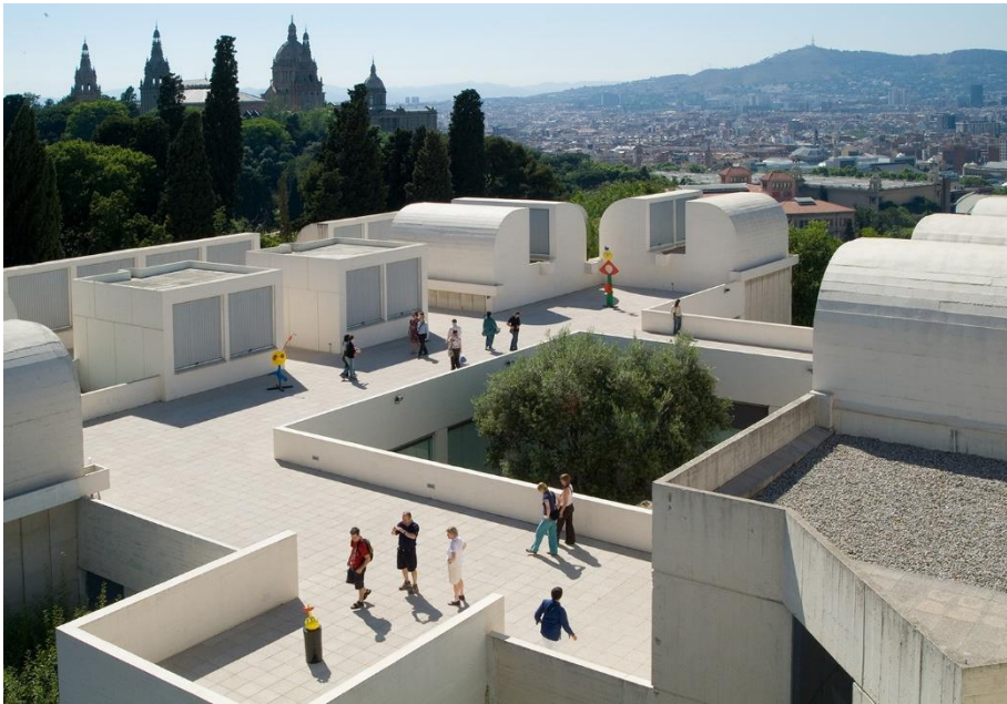
Aerial view of the Fundació Joan Miró, Barcelona. Photo: Pere Pratdesaba
